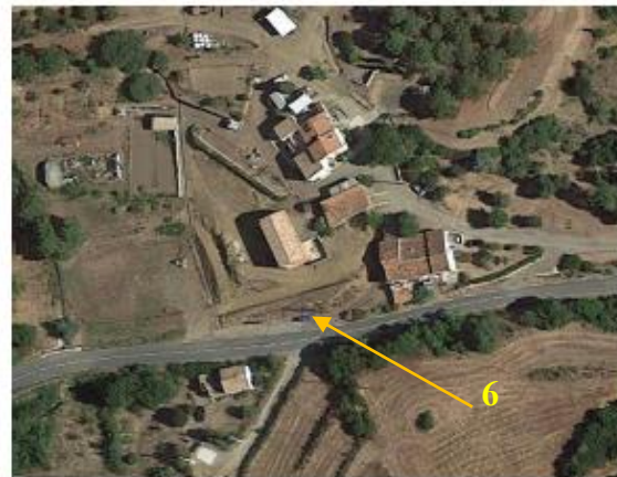
L'Escougoussou (route départementale 19)
